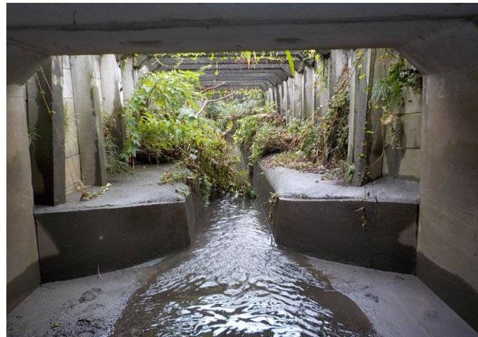
写真手前の小深第一公園側はいつも冠水しているが、その先の四街道市側は全く冠水していない、奥の突出したコンクリートを削り水流を良くします
