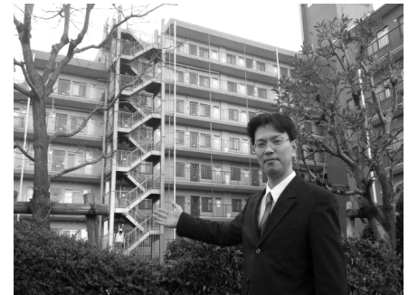
2度目の再建築で6階以上の住民の部屋が奪われなくなりました。
